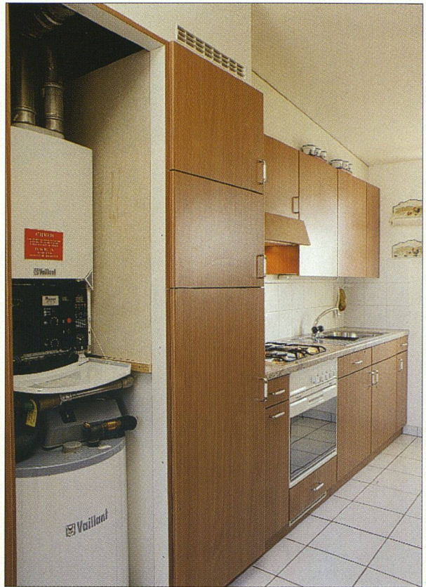
Die Gasheizung samt Boiler haben in einem Schrank Platz.
