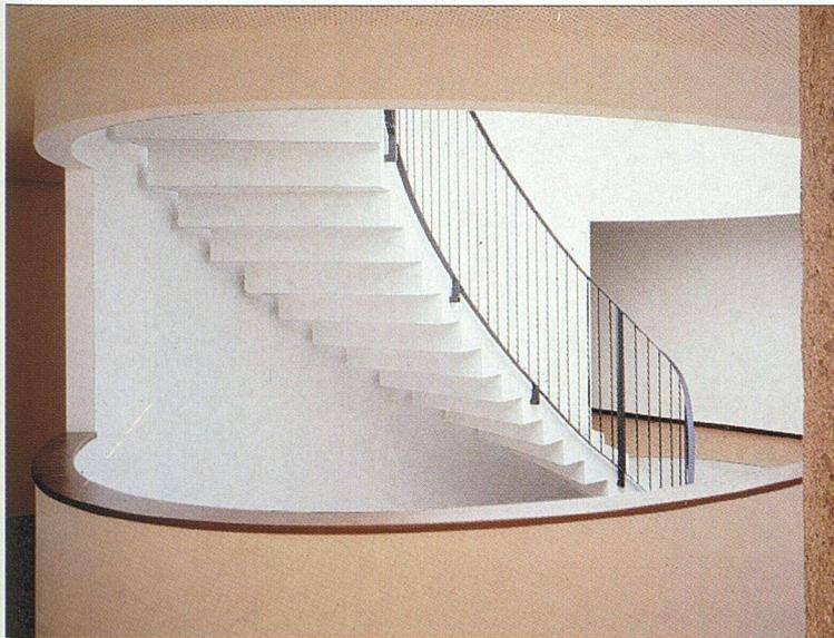
mer zwei Wohnungen zu betreten sind. Der konstruktive Rahmen, auf dem das Dach des Stiegenhauses ruht, setzt sich aus vier Säulen mit grobkörniger Oberfläche zusammen. Innerhalb dieses Rahmens schrauben die Läufe einer elliptisch gewendelten Treppe sich nach oben, dem natürlichen Licht entgegen, das senkrecht in die Tiefe reicht.
