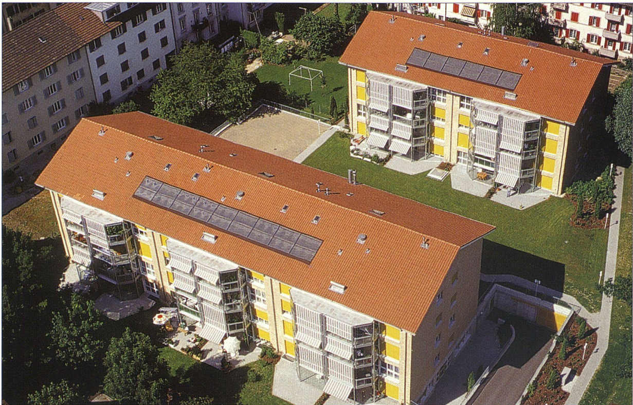
Die beiden viergeschossigen Neubauten bilden quer zum Schneidergässchen eine Art Hofsituation mit grosser Grünfläche. Sonnenkollektoren auf den Dächern besorgen die Warmwasseraufbereitung.
