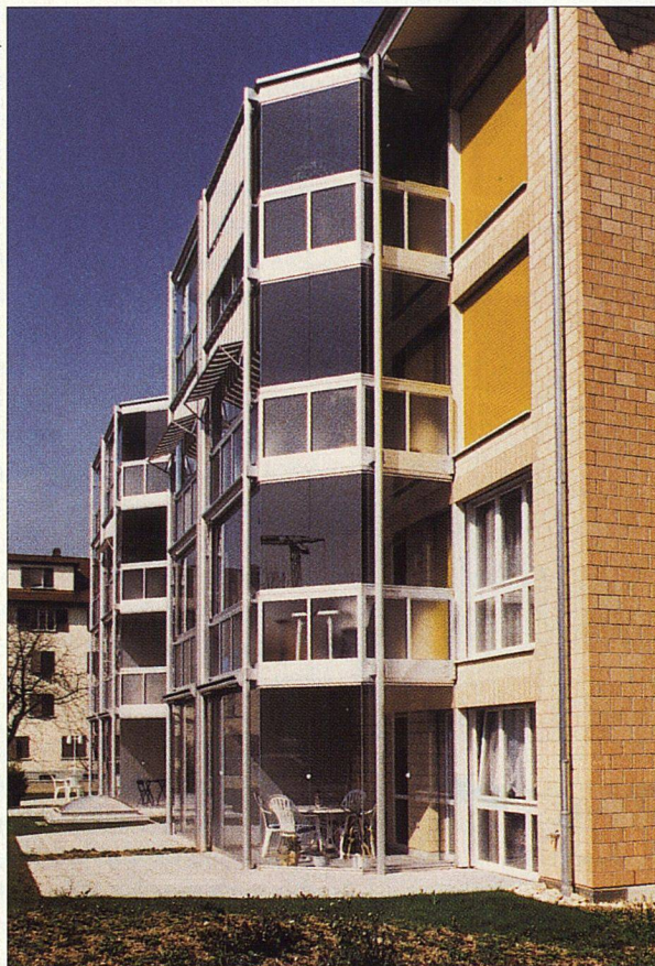
Die Lüftung der Wintergärten erfolgt durch Spalten zwischen den Scheiben sowie durch grosse Schiebefenster.
