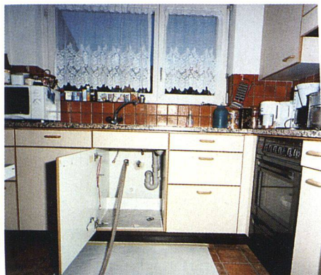
Während der Sanierung konnte die Küche trotzdem benutzt werden.
