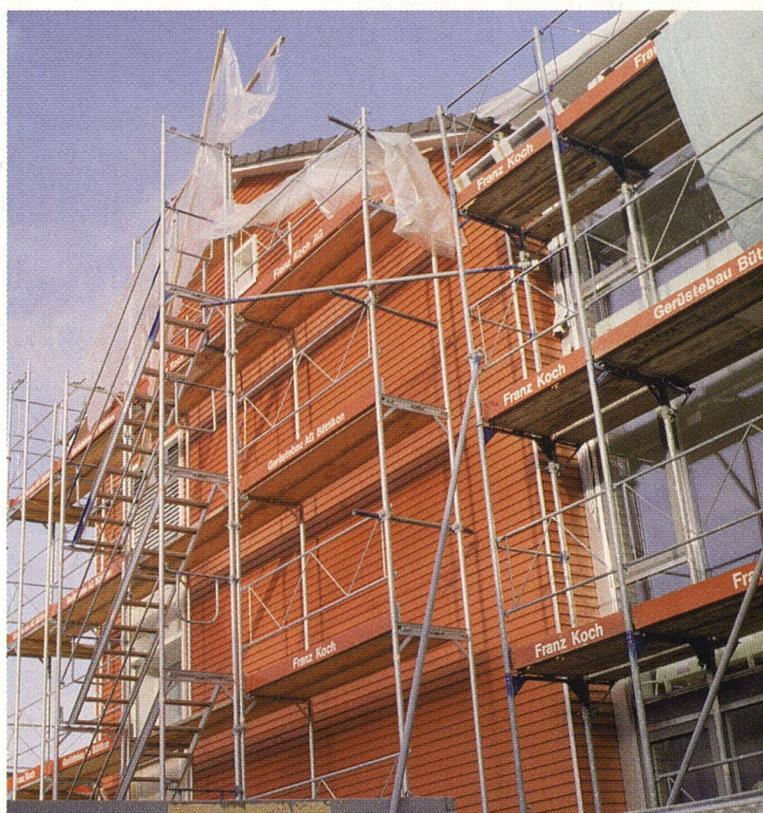
Alle Häuser wurden stark isoliert und mit einem Fassadenkleid in Holz versehen.
