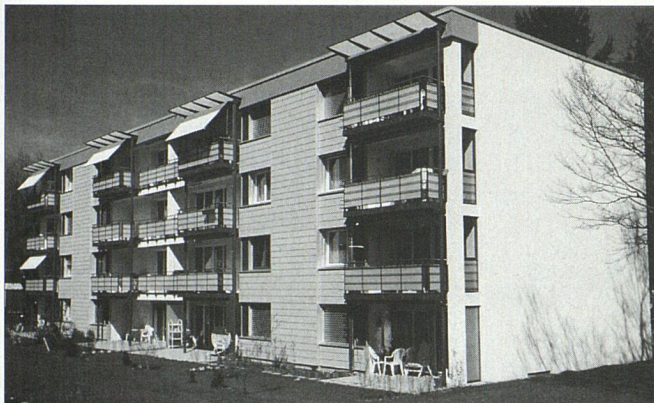
Gesamtsanierung Siedlung Obermatten in Rümlang der Baugenossenschaft ASIG
