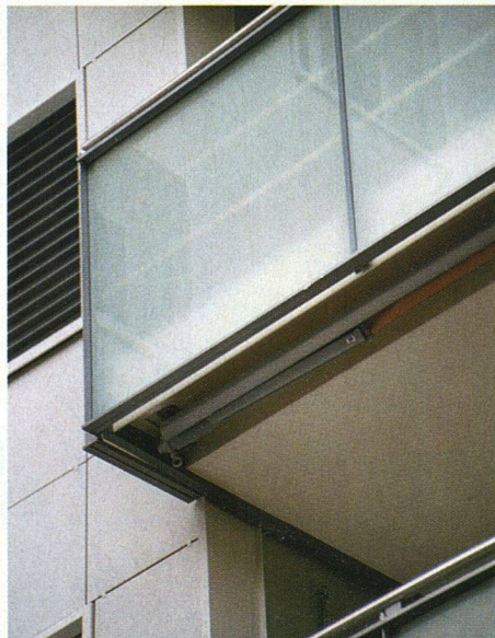
Die Verkleidung der vergrösserten Balkone im Detail
