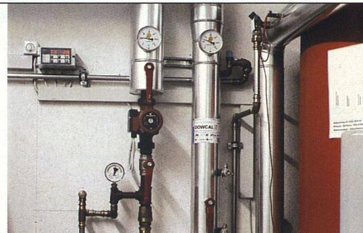
Über einen Wärmeaustauscher liefern die Sonnenkollektoren vorgewärmtes Wasser in die Boiler.
