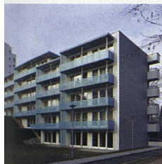
Die Siedlung Friesenberg der Stiftung Alterswohnungen der Stadt Zürich nach der Totalsanierung.
