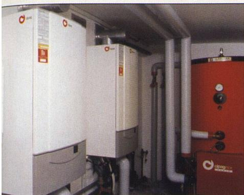
Dachzentrale mit zwei modulierenden 40-kW-Kondensations-Wandkesseln für fünf Wohnungen, Büros und Läden in einem sanierten Altbau in Vevey.
