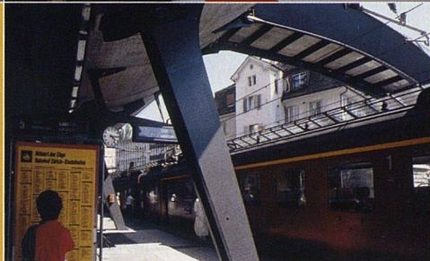
Der Bahnhof Zürich-Stadelhofen von Santiago Calatrava, stimmungsvolle Architektur für den Vorortverkehr.
