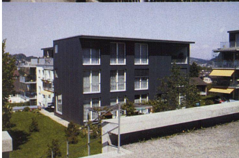
Unter anderem für die geglückte Aufwertung ihrer Sechzigerjahrbauten – hier mit seitlichen Anbauten – erhielt die Genossenschaft den Heimatschutzpreis.
