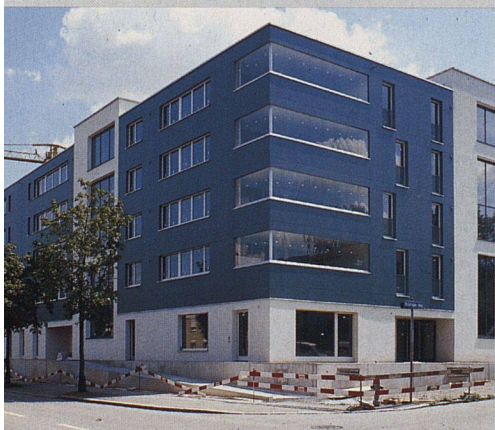
Der Langbau von der Strassenseite; im Parterre sind ein Verein, eine Krippe und Ateliers untergebracht.
