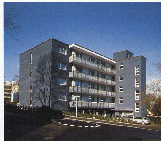
Die Bauten an der Friesenberghalde stammen vom bekannten Architekten Ernst Gisel. Er arbeitete bei der Farbgebung und vielen weiteren Details der Sanierung mit.
