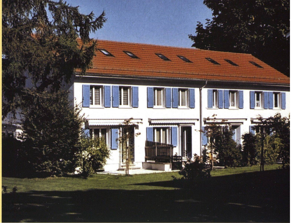
Die Reiheneinfamilienhäuschen wirken nach der Modernisierung frisch und zeitgemäss.
