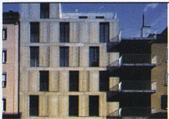
Foto: HLS Architekten
