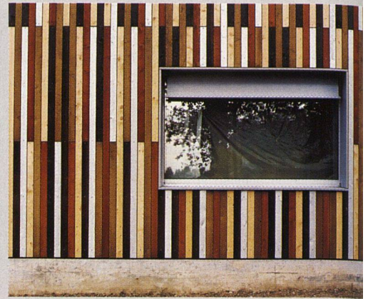
Die Farbtöne der Fassadenverkleidung simulieren den Alterungsprozess des Holzes.
