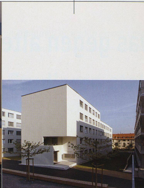
Die drei langgezogenen, viergeschossigen Baukörper sind längs gegeneinander verschoben.
