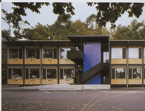
Beispiel für flexibles Bauen: Die provisorischen Schulpavillons sind ganz bewusst für eine begrenzte Lebensdauer konzipiert. Werden sie an einem Ort nicht mehr gebraucht, können sie problemlos auseinander genommen und zum nächsten Einsatzort transportiert werden.
