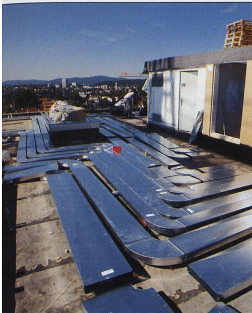
Die Belüftung der Wohnungen geschieht über die Fassade: Auf dem Dach befindet sich die Anlage zur Wärmerückgewinnung.
