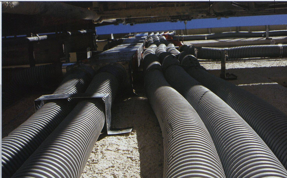
Die Rohre verlaufen in der – hier noch fehlenden – Isolierungsschicht den Fassaden entlang ...
