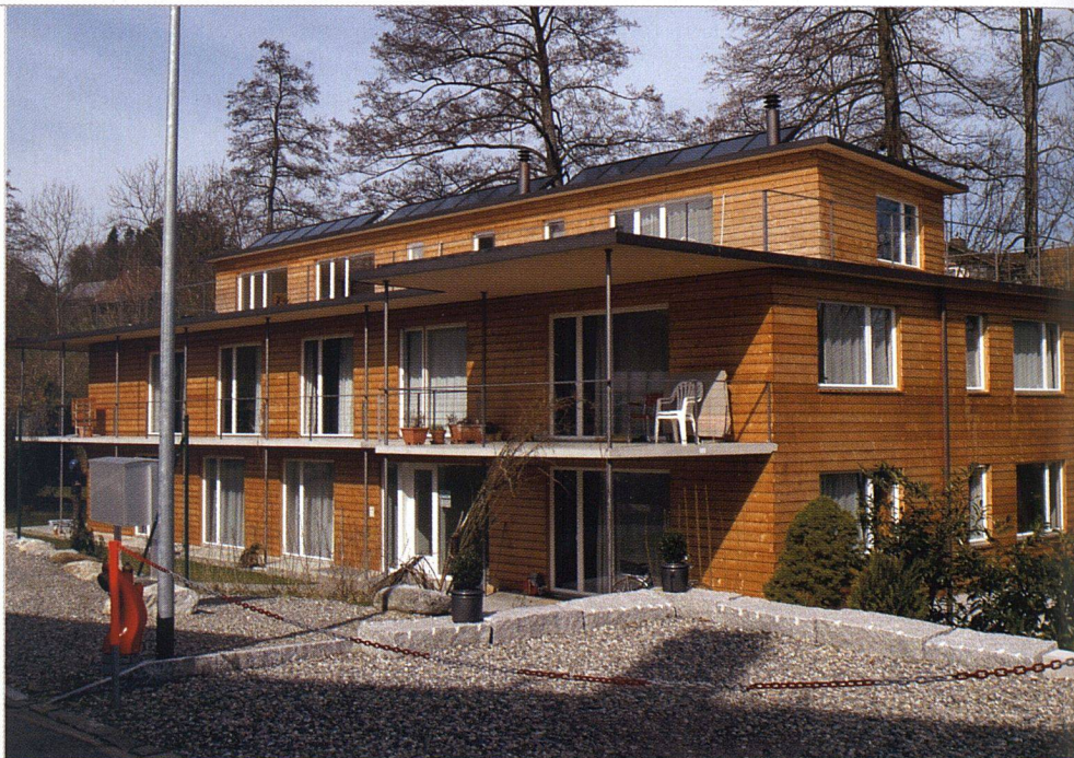
Der Minergie-Bau ist aus Holzelementen gefertigt. Vordächer schützen den Baukörper.
