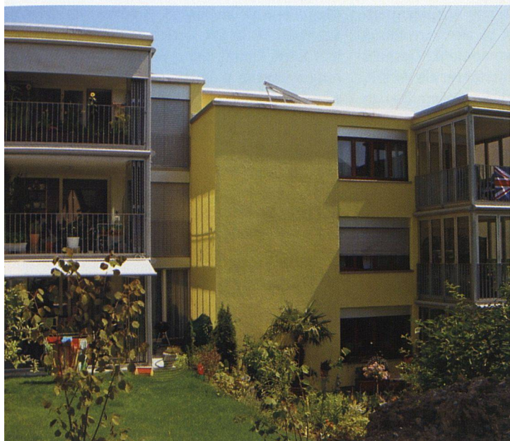
Auch die Dreizimmerwohnungen erhielten einen verglasten Balkon, der während acht bis neun Monaten pro Jahr genutzt werden kann.
