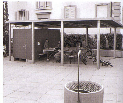
Sicher, ökologisch und nicht teuer: einfacher Brunnen aus einer Betonröhre in einer Siedlung der Stiftung PWG.
