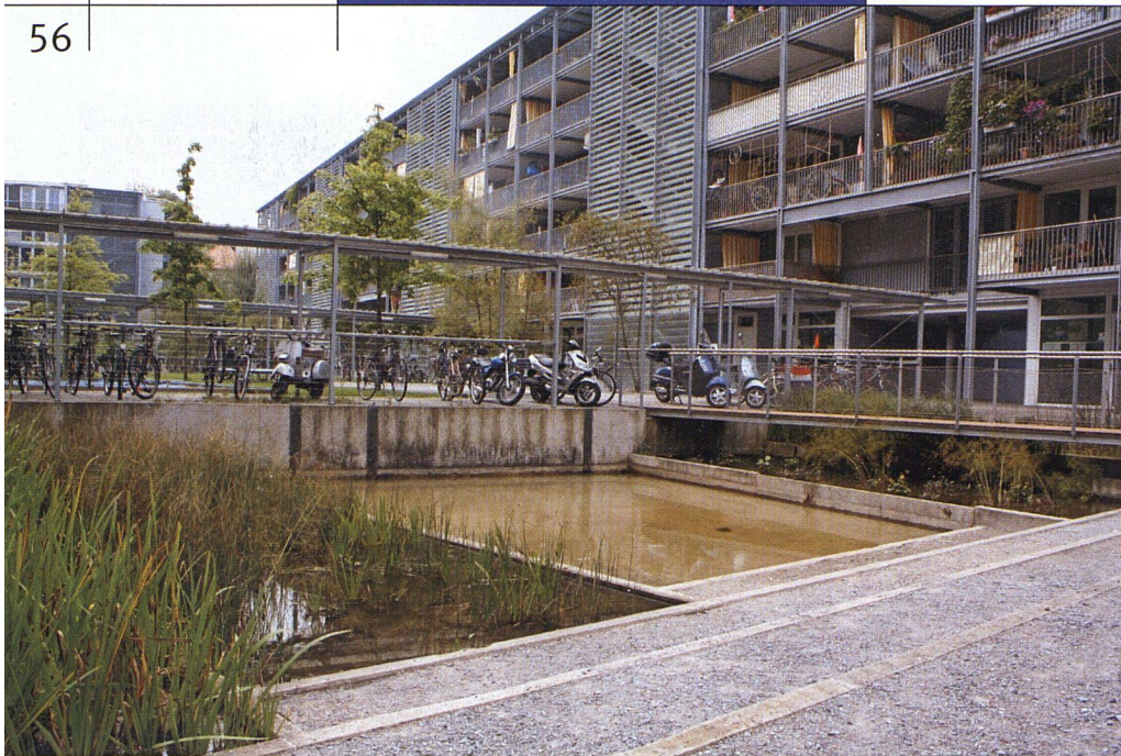
Das Wasserrücklaufbecken in der ABZ-Siedlung Regina-Kägi-Hof überzeugt ästhetisch und ist gleichzeitig attraktiver Spielplatz.
