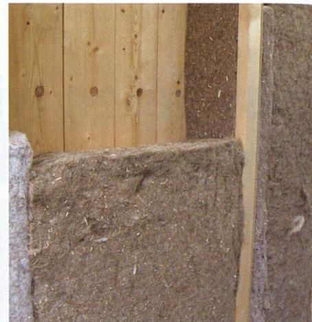
In Deutschland sind Dämmstoffe aus nachwachsenden Naturprodukten wie Wolle oder Hanf weit verbreiteter als in der Schweiz. Eine Ausnahme bildet das Ökohaus in Mosnang (SG), wo eine Dämmung auf Hanfbasis zum Einsatz kam (Bild rechts).
