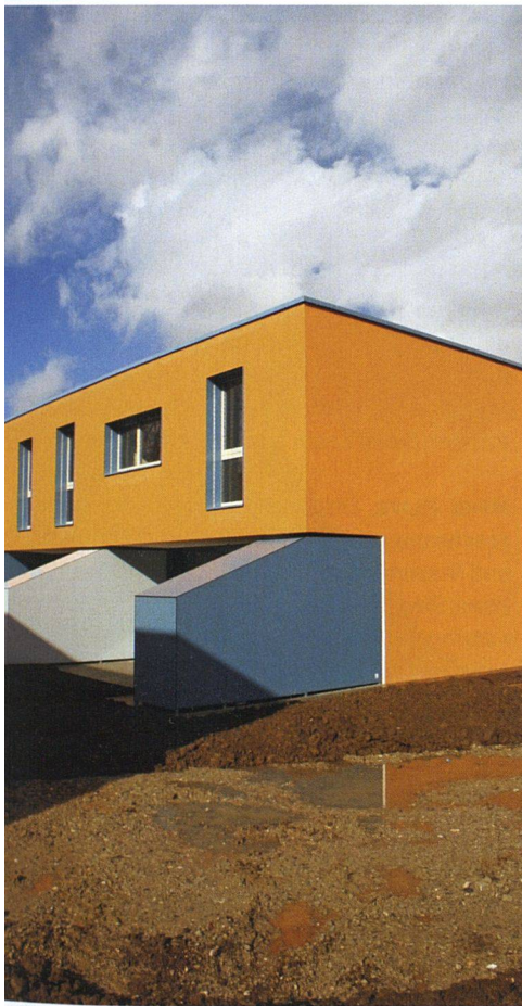
Auch mit Reihenhäusern lässt sich verdichten. Das beweist der Architekt Beat Rothen mit den Ersatzbauten für die Vitasana in Zürich Schwamendingen. Es handelt sich allerdings um das einzige neuere genossenschaftliche Bauprojekt, das auf diese Wohnform setzt.
