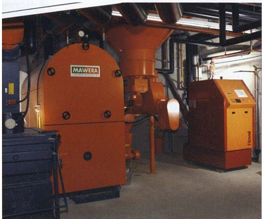
Bei der Siedlung Vistaverde (BG Freiblick und Zurlinden) heizt man mit Holzschnitzeln. Solarzellen übernehmen einen Grossteil der Warmwassererwärmung.
