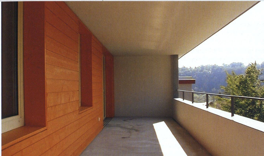
Blick auf einen der neuen 25-m 2 -Balkone.
