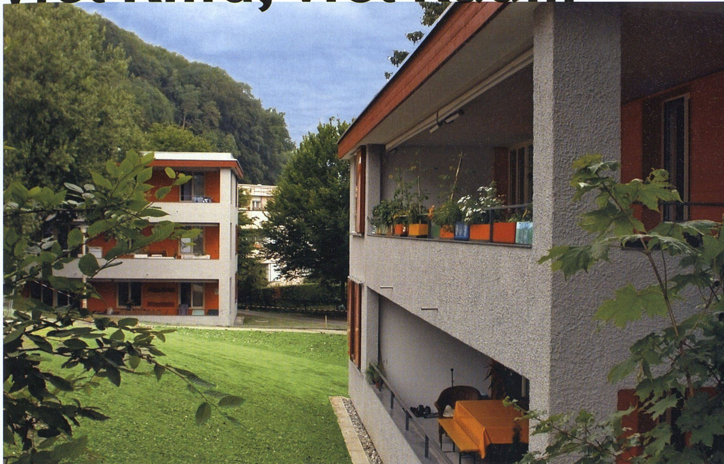
Dank einer neuen Raumschicht erhielten die vierzehn Häuser der Siedlung Leimbach grosszügige Balkone.
