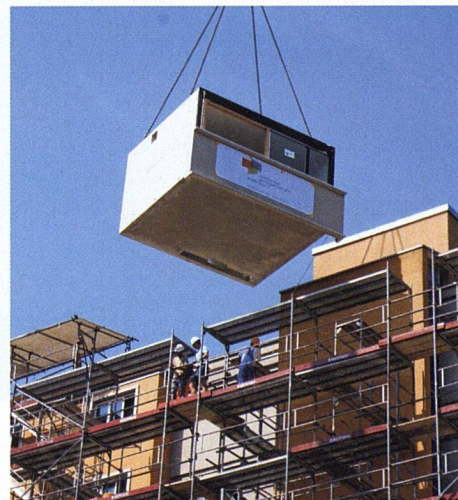
10:02 Uhr: ... in die vorgesehene Baulücke eingepasst ...
