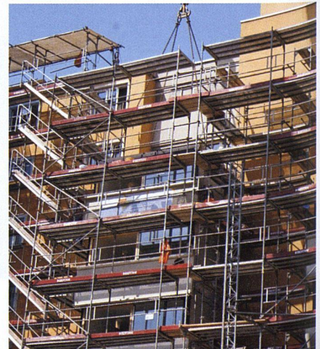
10:11 Uhr: ... und passgenau auf das vorherige Element abgesetzt.
