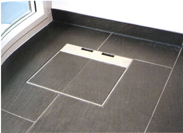
Die Baugenossenschaft Vitasana hat in ihren neuen Reihenhäusern in Zürich Schwamendingen alle Zimmer mit praktischen Steckdosen für alle möglichen Anschlüsse ausgestattet – und diese geschickt im Boden versenkt.
