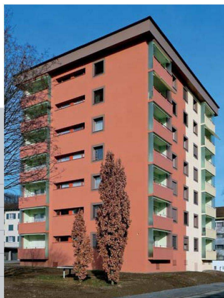
Die neue Kompaktfassade bietet zeitgemässen Wärmeschutz.
