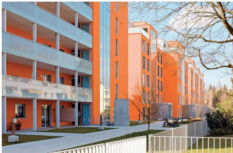
Blick auf die Eingangsseite der ersten Etappe.
