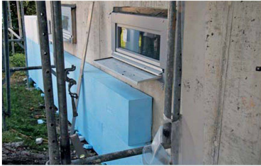
Das Rezept: Eine starke Dämmung. Die Aussenfassade wurde in 25 cm dicke EPS-Platten verpackt.
