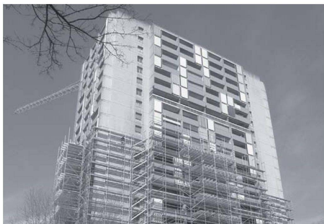
Gesamterneuerung Hochhaus mit 120 Wohnungen im Schwabgut Bern
