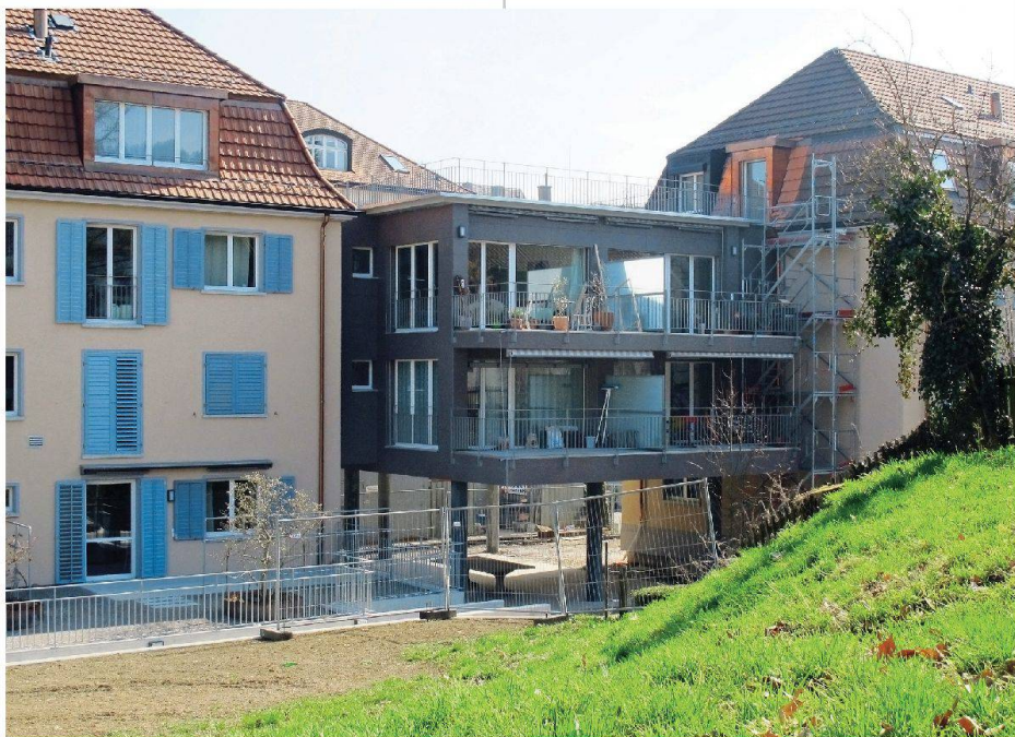
Mit zwei Zwischenbauten schafft die BGZ 2 rund 500 Quadratmeter zusätzliche Wohnfläche.
