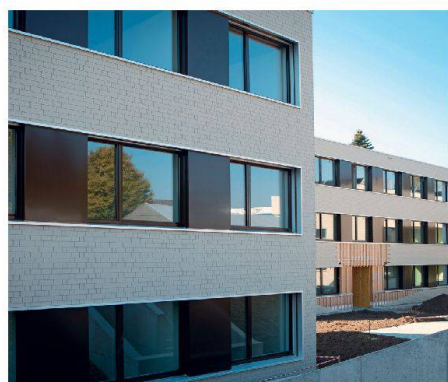
Blick auf die Eingangsseite.
