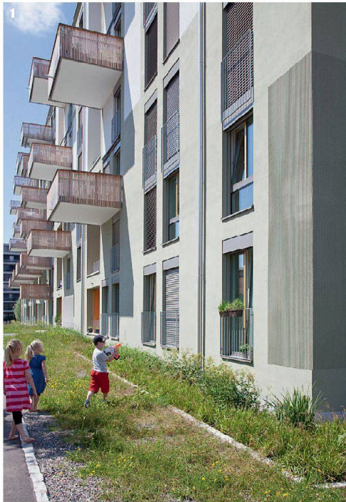
1 Eine Art Burggraben, wo das Dachwasser versickern kann, zieht sich ausserhalb der Häuser.
