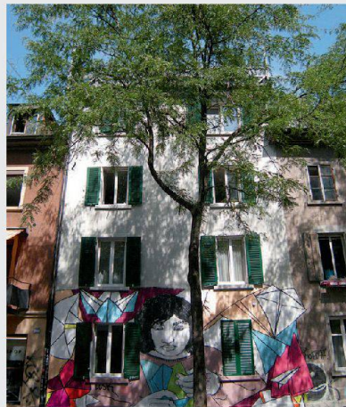
Künftig soll hier noch eine weitere Wohnung für selbstverwaltetes und kollektives Wohnen entstehen.
