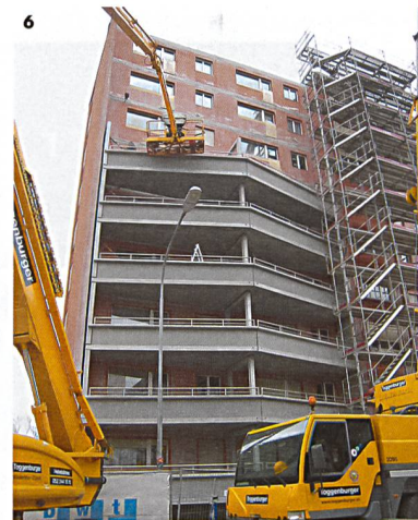
6 Bauzustand: Die alten Balkone sind vollständig entfernt, die neue Balkonschicht aus Fertigteilen wächst empor.
