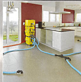
Wasserschadentrocknung
