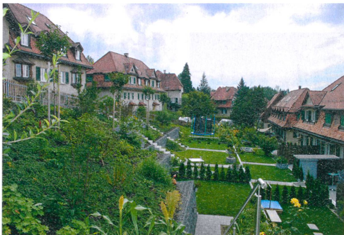
Die Vorgärten sind nach der Verlegung des Nahwärmenetzes wieder instand gestellt worden.
