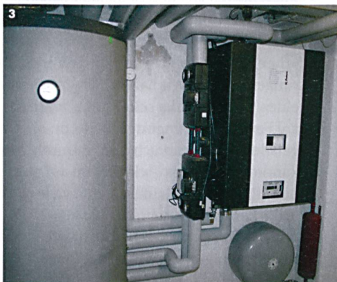
1 Zuleitung der Fernwärme vom Hauptstrang in der Übergabestation im alten Geschäftshaus.
