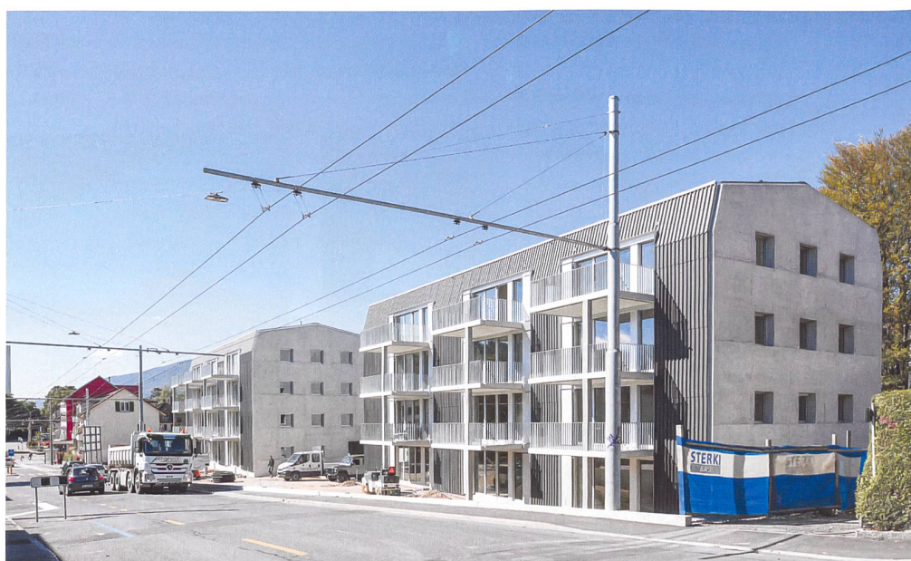
Die Neubauten vom Geyisriedweg aus gesehen.
