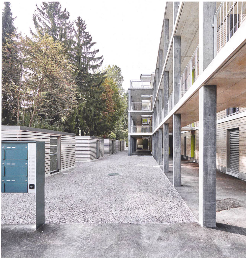
Die Erschliessung erfolgt über Laubengänge, die etwas von der Fassade abgesetzt sind.
