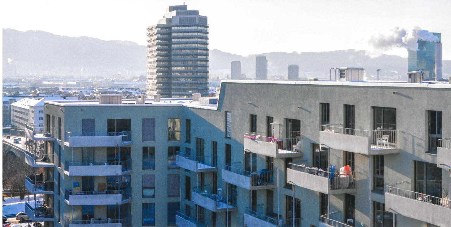
Die gesamte Betriebsenergie wird lokal gewonnen, mit Erdsonden und Photovoltaikanlagen auf den Dächern. Ausblick vom oberen Gebäudeteil an der Nordstrasse Richtung Innenhof und Limmathochhaus.
