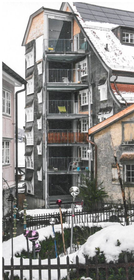
Lift und neue Balkone auf der Rückseite.
