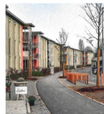
Die Ersatzneubauten der Baugenossenschaft Schönau in Zürich Seebach fügen sich ins Bild der Dorfsiedlung. Bild: Katja Jug
