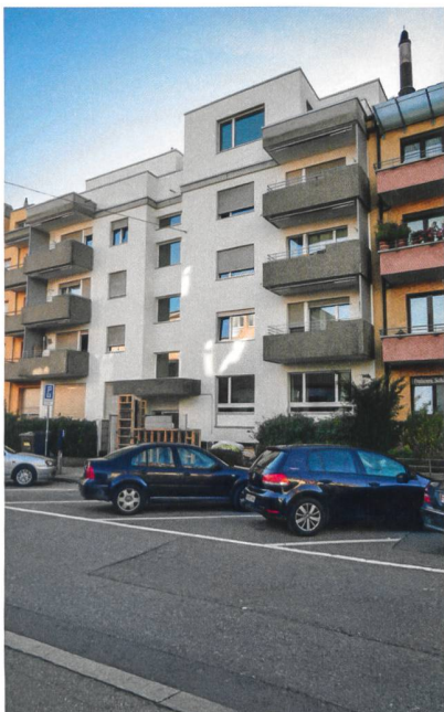
Das Haus an der Friesstrasse 35 in Zürich Oerlikon bietet dank der Aufstockung neu eine 10-Zimmer-Attikawohnung.
