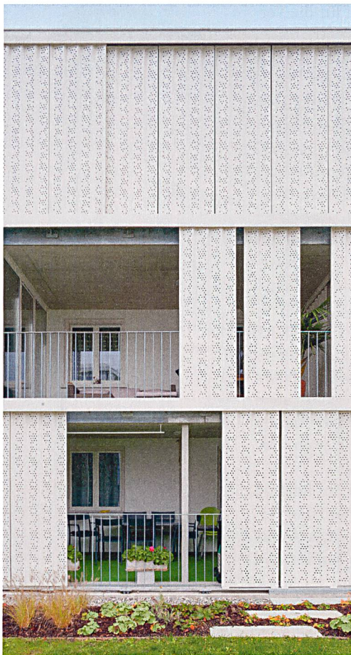
Schiebelamellen dienen als Sonnen- und Blickschutz.
