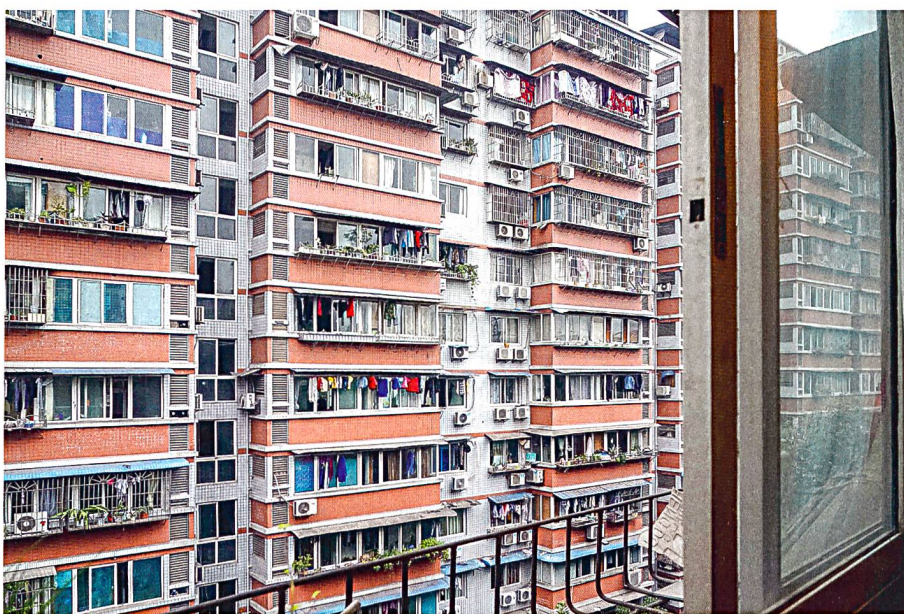
Wohnblocks wie hier in Chongqing sind in den Millionenstädten Südchinas meist nicht isoliert und haben nur einfachverglaste Fenster.
