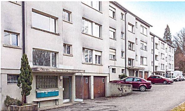
Der erneuerungsbedürftige Bau von 1969 wird durch zwei Häuser mit modernen Genossenschaftswohnungen ersetzt.
