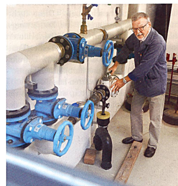
Die Wartung von Wasserinstallationen umfasst Anschlüsse und Leitungen ebenso wie die Kontrolle von Temperaturen und Drücken. Bild: Reparaturmann Hans Junker im Einsatz im Hochhaus Schwabgut der Eisenbahner-Baugenossenschaft Bern.
