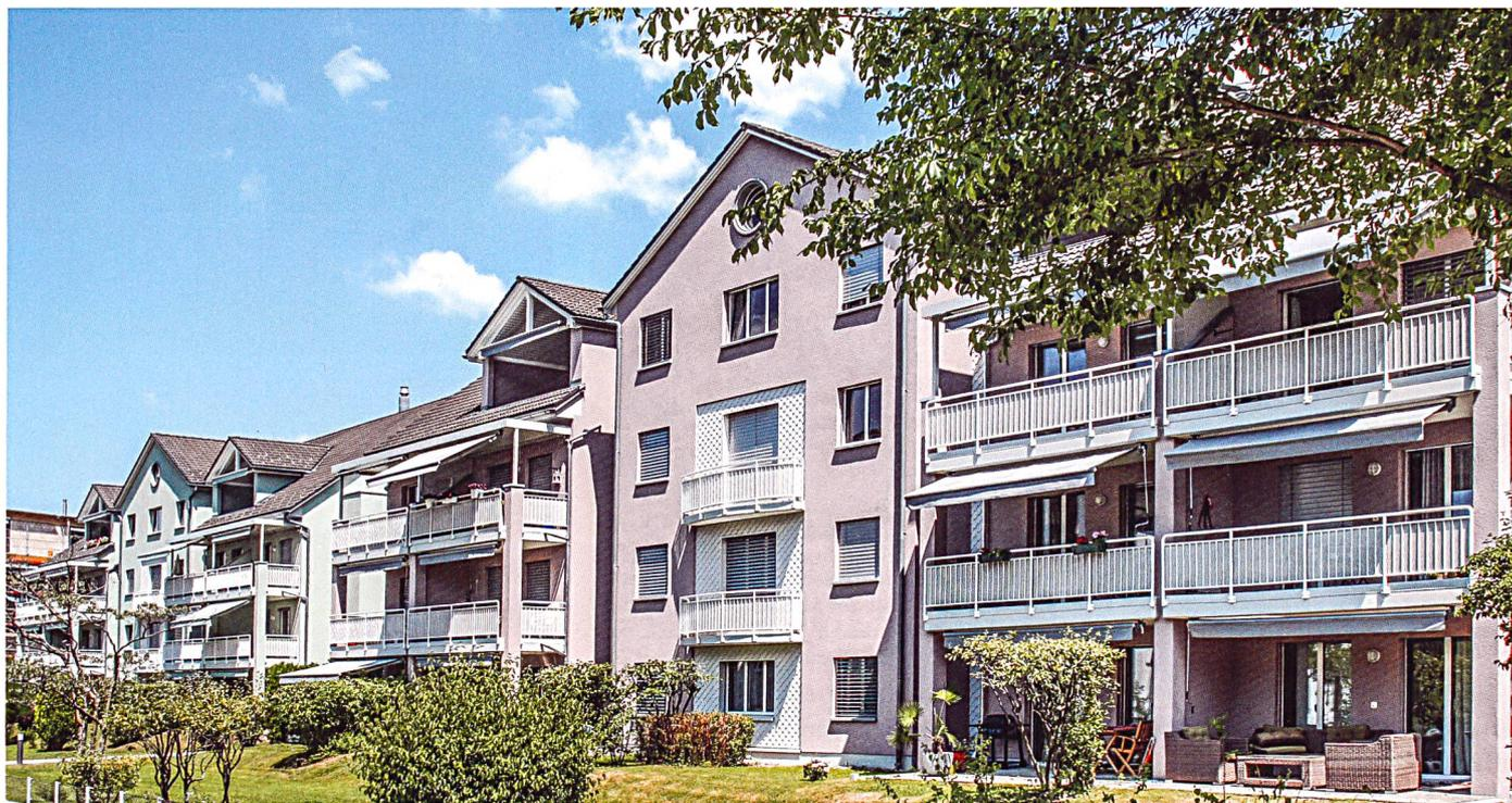
Die neue Minergie-Systemerneuerung umfasst fünf vordefinierte Sanierungsvarianten, die zum Minergie-Zertifikat führen. Beim gut 20-jährigen Mehrfamilienhaus in Schänis kam Systemvariante 2 zum Zug, bei der auf eine neue Dämmung der Gebäudehülle verzichtet werden konnte.
